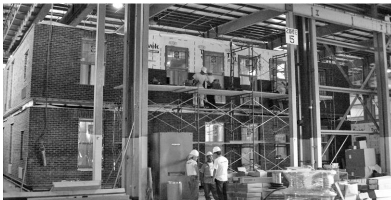
ייצור ואחסנה במפעל של יחידות מודולריות למעונות סטודנטים
