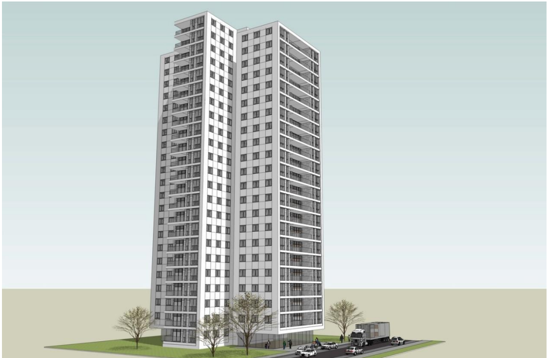
ציור 8.1.3: בניין מגורים המבוסס על יחידות מודולריות תלת ממדיות
